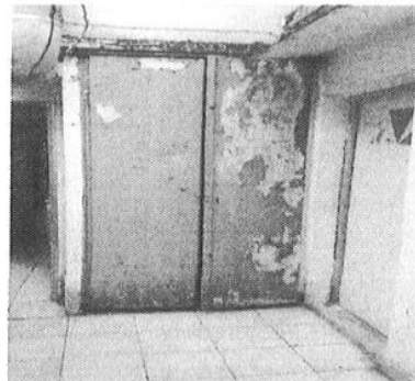
Photo 4 : Cour - Porte du placard électrique.
